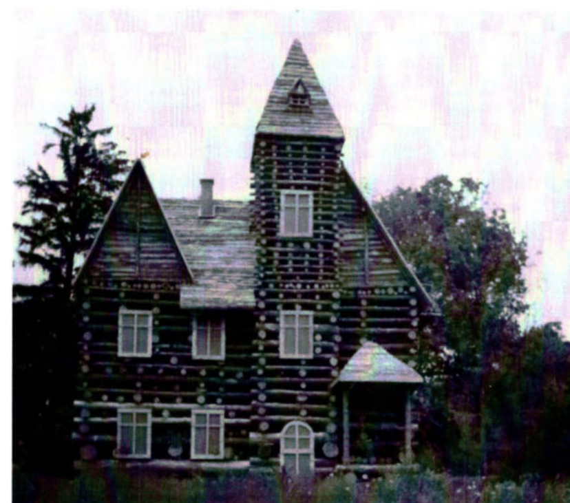
Juin 1987 Le magnifique bûcher de la Saint-Jean édifié par les pompiers, à l'image du « Château », la résidence des Lefébure à la Camme
